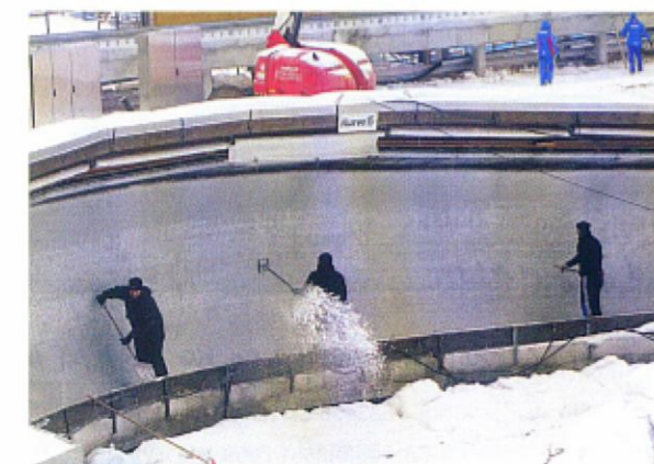
Vorbereitung für die ersten Testfahrten
